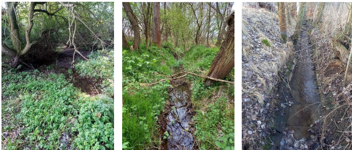
Obr. 23 Nalevo přírodě blízká, uprostřed zahloubená a napravo zahloubená a opevněná část horního toku Hrádeckého potoka. (Zdroj: Archiv ŽV)
