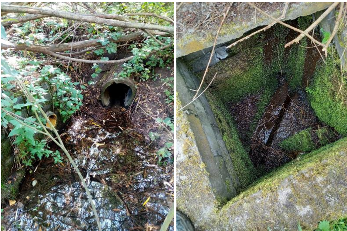
Obr. 24 Zmapovaná vyústění meliorací a meliorační šachty. (Zdroj: Archiv ŽV)
