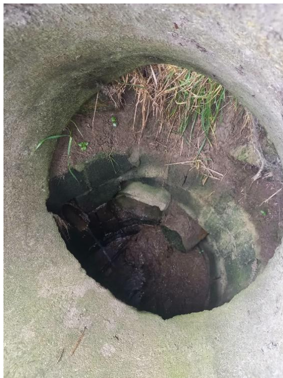
Obr. 19 Vlevo meliorační šachty a eroze v údolnici, vpravo pohled do šachty na trubky odvodňující krajinu i v období sucha, k. ú. Červený Hrádek. (Zdroj: Archiv ŽV)
