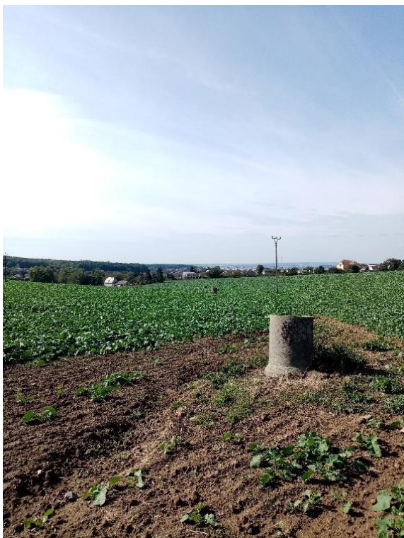
Obr. 19 Vlevo meliorační šachty a eroze v údolnici, vpravo pohled do šachty na trubky odvodňující krajinu i v období sucha, k. ú. Červený Hrádek. (Zdroj: Archiv ŽV)
